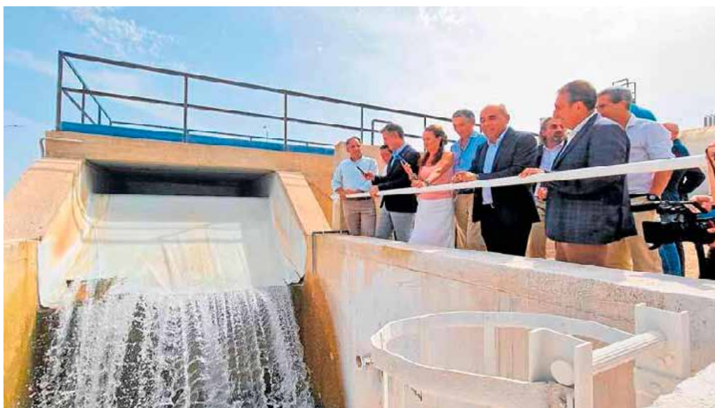
Puesta en marcha de la nueva desaladora que suministrará de agua los cultivos de Almería y el Campo de Níjar.
